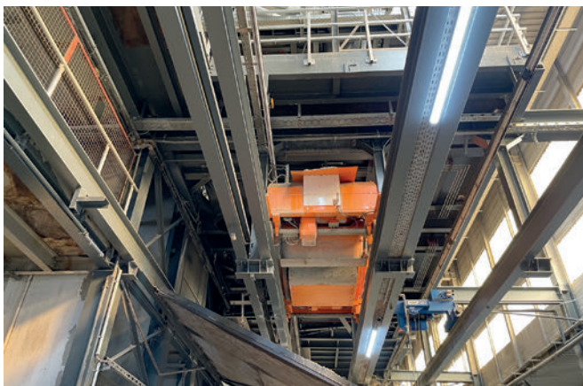
Dos cubas aéreas Kübat se encargan del transporte de hormigón a la producción
