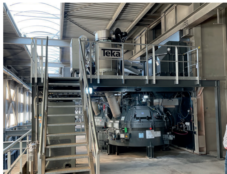
Vista de la nueva instalación mezcladora de Lithonplus
