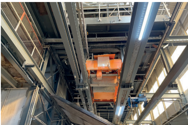
Zwei Kübat-Kübelbahnen sorgen für den Betontransport in der Produktion
