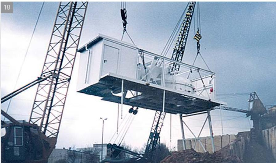
18-22 | Монтаж MIXOMAT THZ 3000 C 1 - R с TEKA высокопроизводительным тарельчатым смесителем, отдельные смесительная и весовая платформы в виде модулей и полноценной теплоизоляционной обшивкой.
