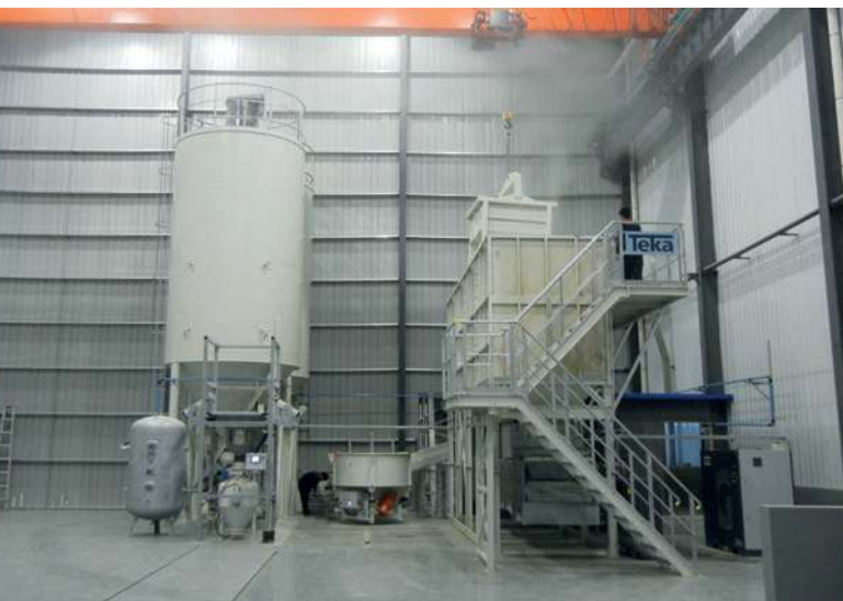
Reihensilos und Zementsilos
