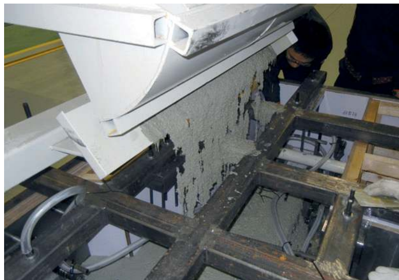
Betonieren des ersten Bauteils
